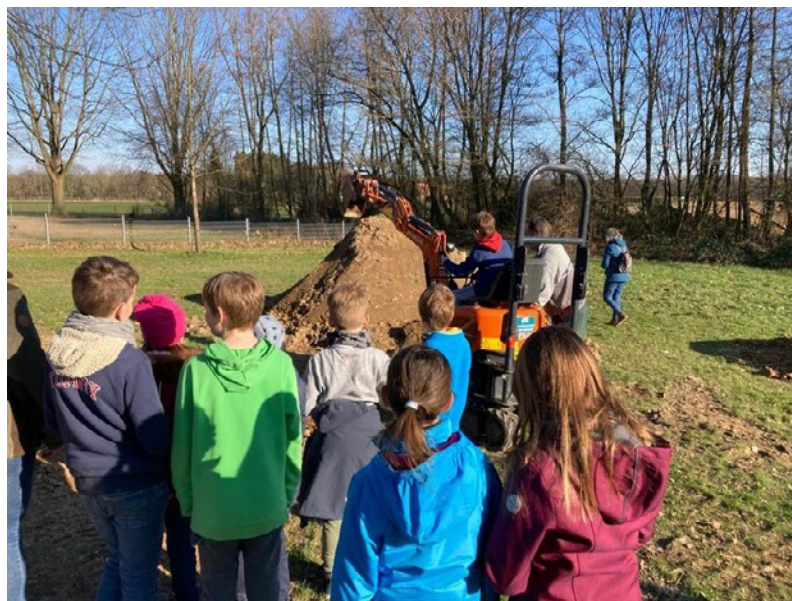
Baustellensprechstunde mit Bagger (© Verena Wagner / Biologische Station Haus Bürgel, 2022)
