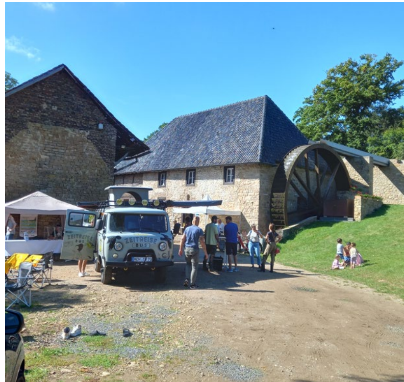
Zeitreisebus Embkener Wassermühle (© Biologische Station Düren)
